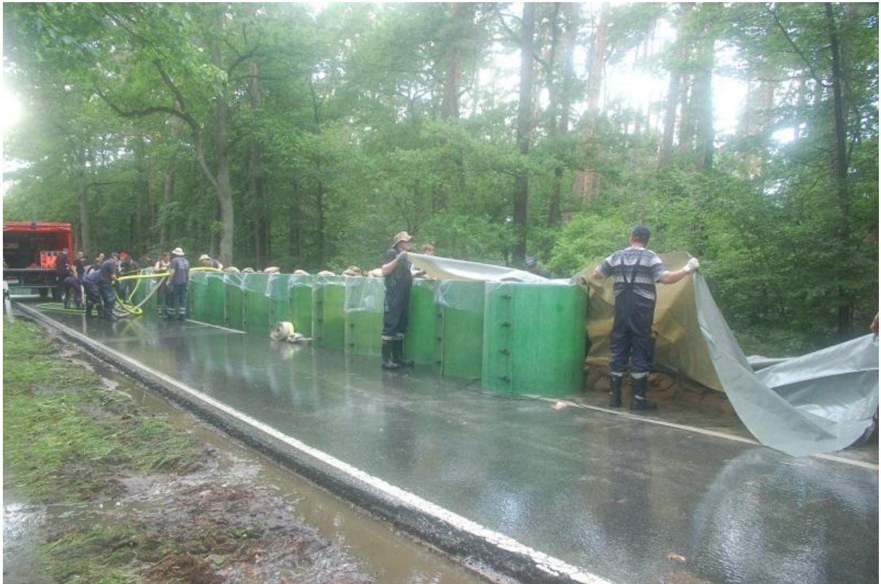
Kreisfeuerwehrbereitschaft Landkreis Verden – Aufbau eines mobilen Hochwasserschutzsystems
